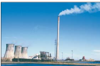
CENTRAL TÉRMICA DE CARBÓN
